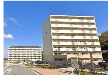
建設年度：平成 27・29 年 構造/階数：高層耐火/8 階 管理戸数：126 戸 住戸専用面積：42.93~72.85 ㎡
