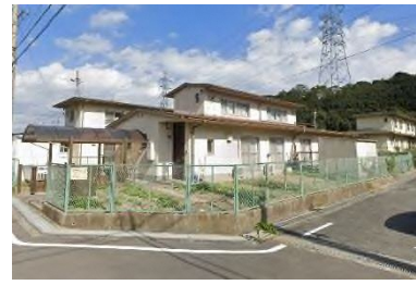
建設年度：昭和 61～平成 7 年 構造/階数：低層耐火/2 階 管理戸数：60 戸 住戸専用面積：69.9 - 72.1 m 2
