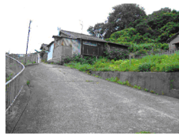
建設年度：昭和 27・28 年 構造/階数：木造/1 階 管理戸数：1 戸 住戸専用面積：28.0 ㎡
