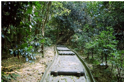
関西電力多奈川第二発電所「緑と憩いのエリア」
