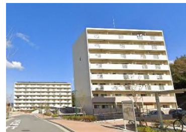
建設年度：平成27(2015)・29(2017)年 構造/階数：高層耐火/8階 管理戸数：126戸 住戸専用面積：42.93~72.85㎡
