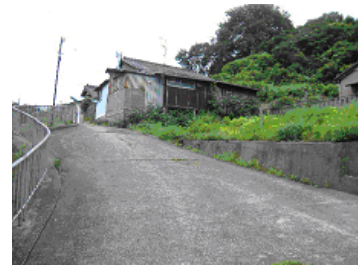
建設年度：昭和27(1952)年 構造/階数：木造/1階 管理戸数：1戸 住戸専用面積：28.0㎡
