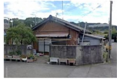
建設年度：昭和29(1954)年 構造/階数：木造/1階 管理戸数：6戸 住戸専用面積：34.7㎡
