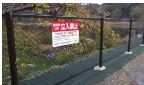
立入禁止看板の設置
