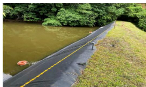
応急処置状況(ロープ、浮輪、救助ネット)
