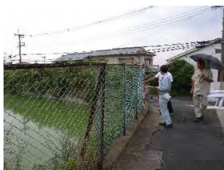
安全柵の点検状況
