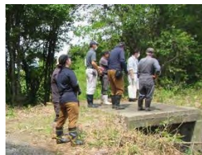
緊急点検の実施状況
