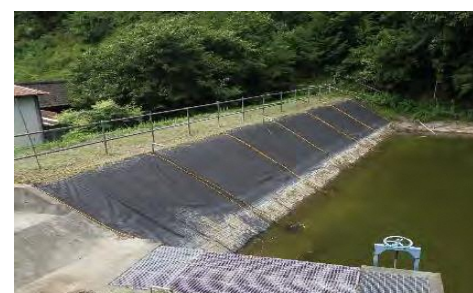
救助ネットの設置状況
