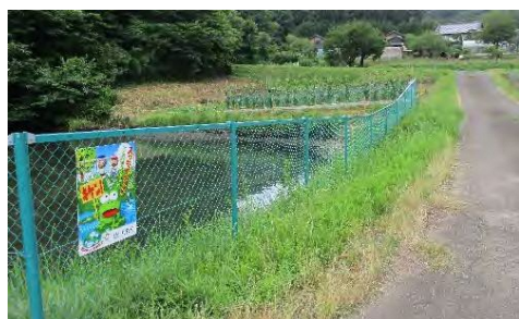
ネットフェンスの設置状況
