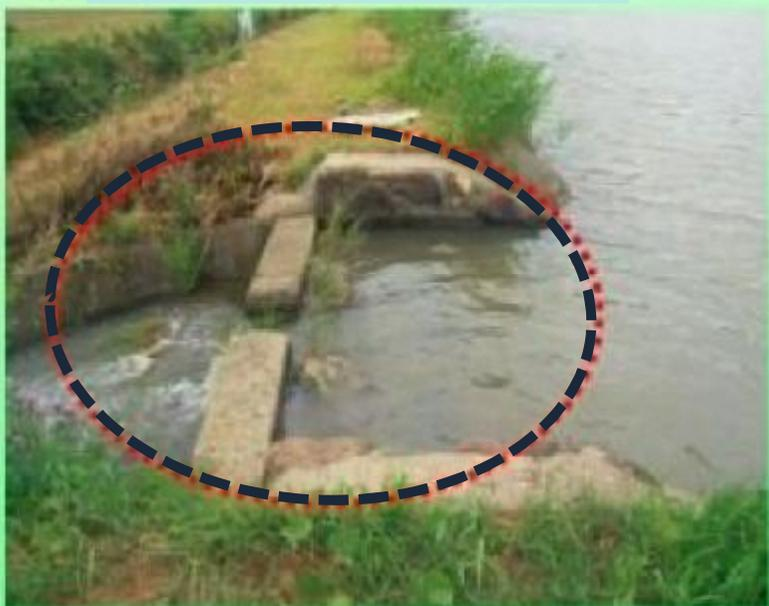
⑧ 継目、亀裂からの漏水(水路壁の変色)
