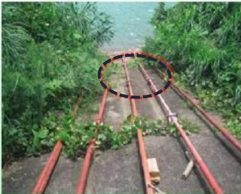
⑥斜樋底部の陥没
