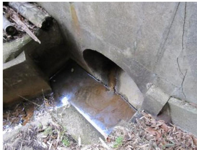
底樋管の破損による閉塞
