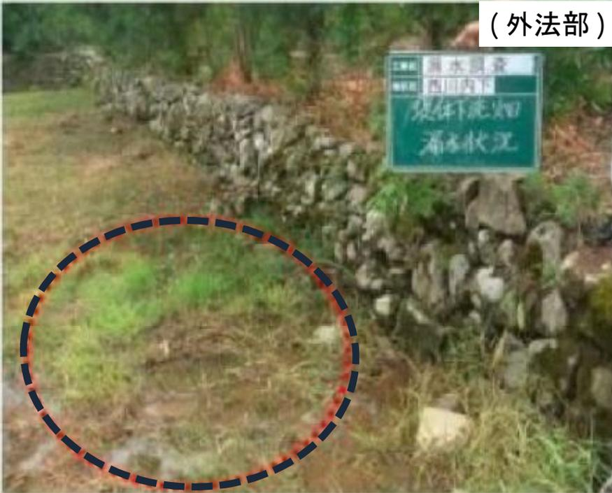
④染みだしやパイピングによる漏水
