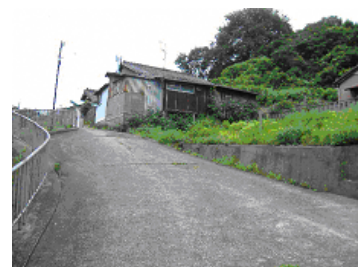
建設年度：昭和27(1952)年 構造/階数：木造/1階 管理戸数：1戸 住戸専用面積：28.0㎡
