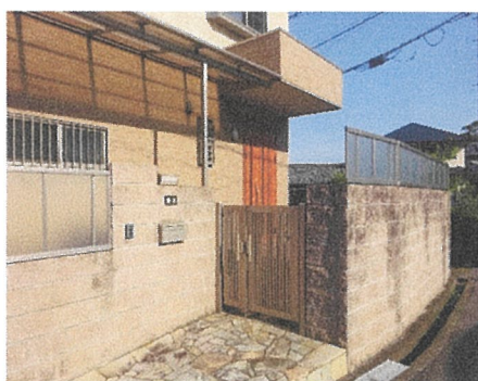
#417 門日玄関アプローチ
