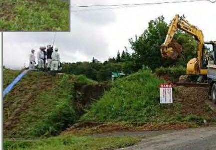
▲排水ポンプ車 による排水 (最大30トン/分 の排水が可能)
