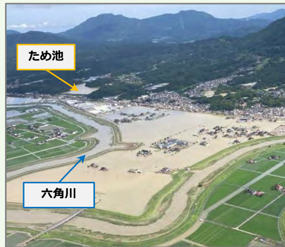
▲豪雨による被災状況
