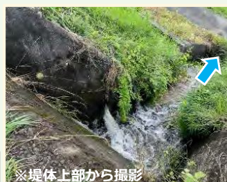
※堤体上部から撮影
