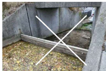
堰板によるかさ上げ
