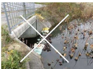
土のうによるかさ上げ
