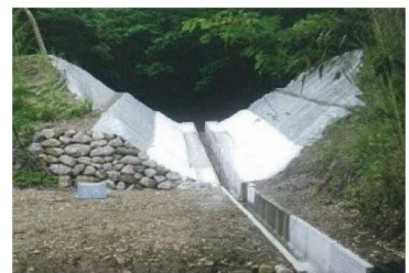
廃止工事（開削）
