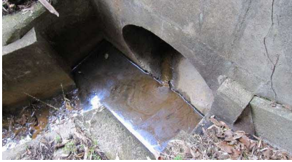
底樋管の破損によりゲートを閉めても 水が出ている事例
