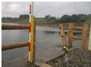
破損箇所にロープ等で侵入防止措置を講じ、速やかに補修
