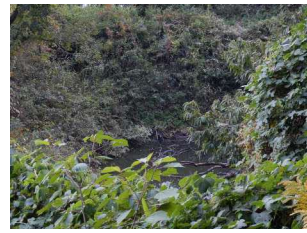
ため池全体が高木や雑草繁茂により、 接近出来ない状態
