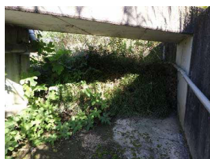
余水吐を土嚢で閉塞 H≒1.0m
