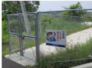
侵入防止フェンスの設置
