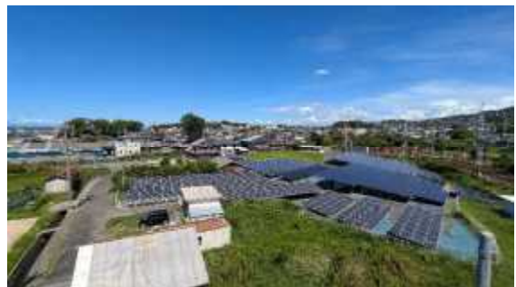
南海本線の海側に設置されている太陽光パネル
