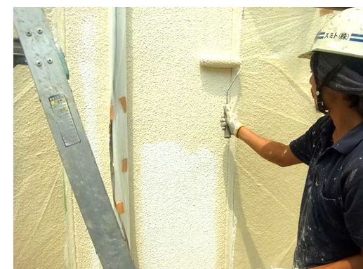
外壁改修工事 (塗装替え)
