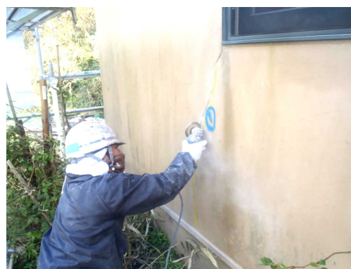
外壁改修工事 (ひび割れ補修等)
