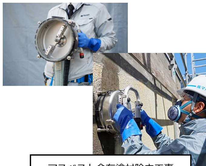
アスベスト含有塗材除去工事 (外壁)
