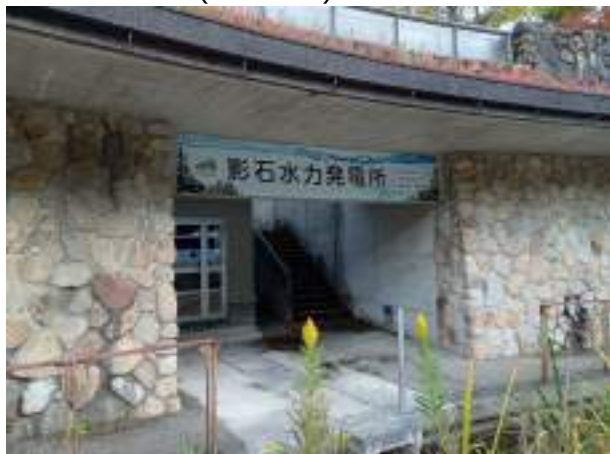
写真 20：影石水力発電所外観
