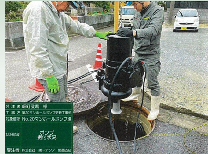
⑥マンホールポンプ更新事業 （下水道事業特別会計分） 2,600千円
