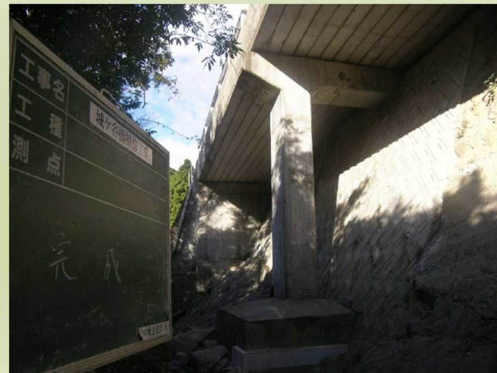
④橋りょう整備事業等（城ヶ谷橋）8,100千円
